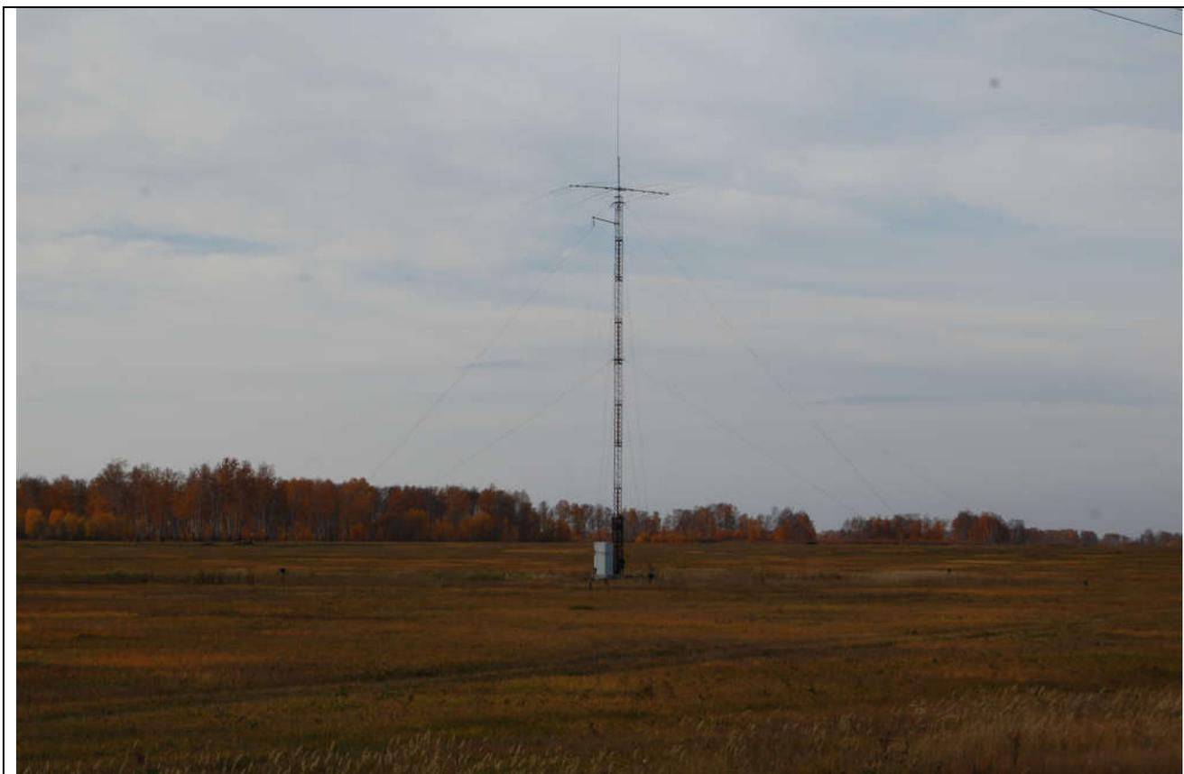
КВ трайбендер типа AD335, Inv V на 7 и 3,5 МГц и коллинеарная антенна на диапазоны 144 и 430 МГц. Всё оборудование, включая трансивер, расположено в термостабилизированном шкафу внизу мачты.
